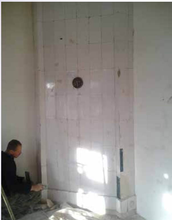
Илл. 19. Проемная печь в усадьбе Аигиных ASG. Реставрация
