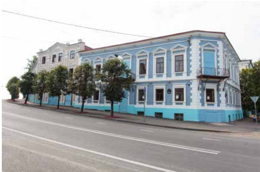
Номера Михайлова. г. Казань, ул. Лобачевского, 3. В процессе реставрации
