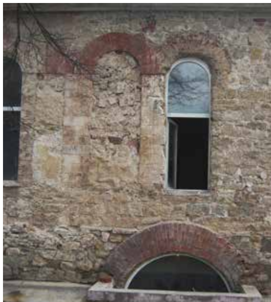
Илл. 3. Зондажное раскрытие западного фасада
