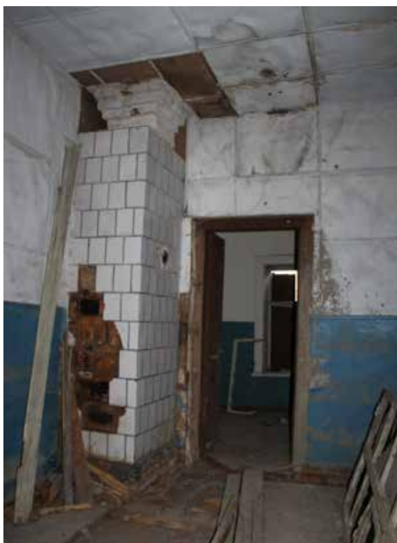
Илл. 11. Подлинная печь, облицованная керамическими изразцами с синим кантом
