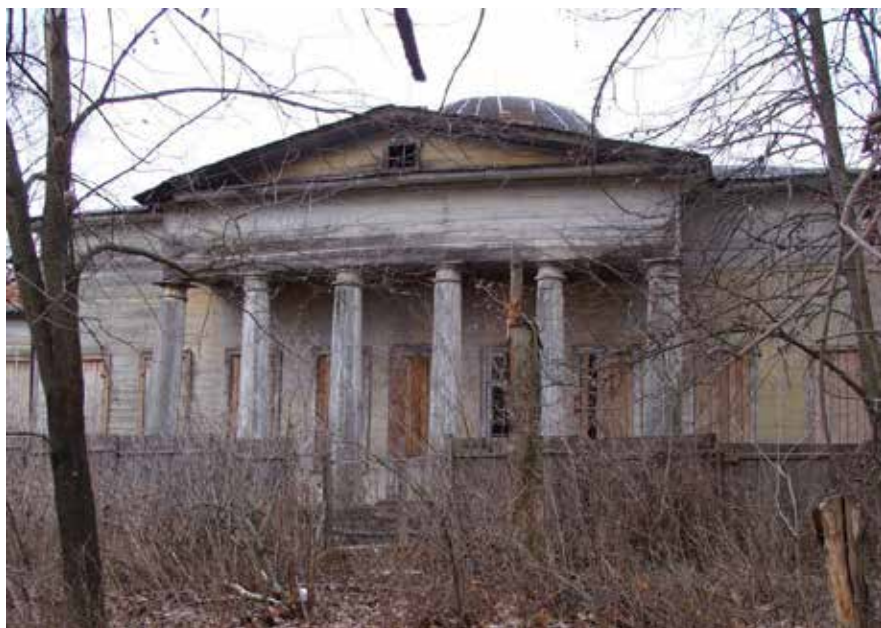
Илл. 4. Шестиколонный портик главного фасада
